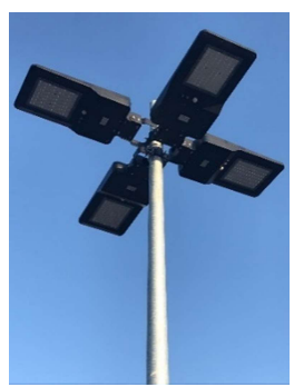
Exemple de réalisation de montage possible
