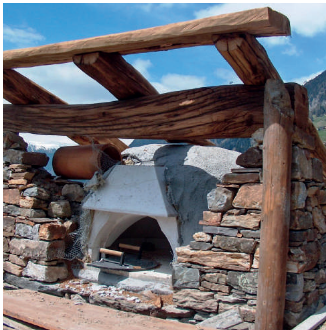
(ci-contre) Montage en cours d'un de nos fours
