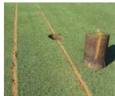
La rainure est remplie de sable jusqu'à 15 - 22,5 cm de profondeur.
